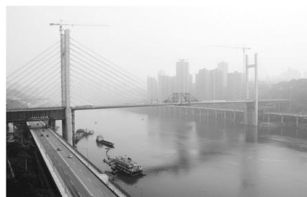
近日,由中交一公局三公司承建的重庆轨道交通环线高家花园嘉陵江大桥(如上图)合龙。该桥是目前国内最大跨径的轨道专用斜拉桥,长594米,主桥为双塔双索面混合梁斜拉桥。
